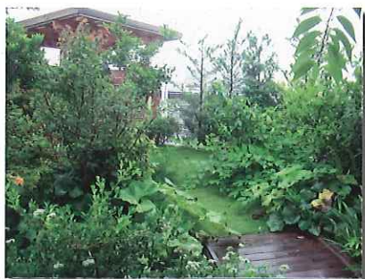
老人保健施設「エルダリーガーデン」の屋上に設置された緑の庭園
